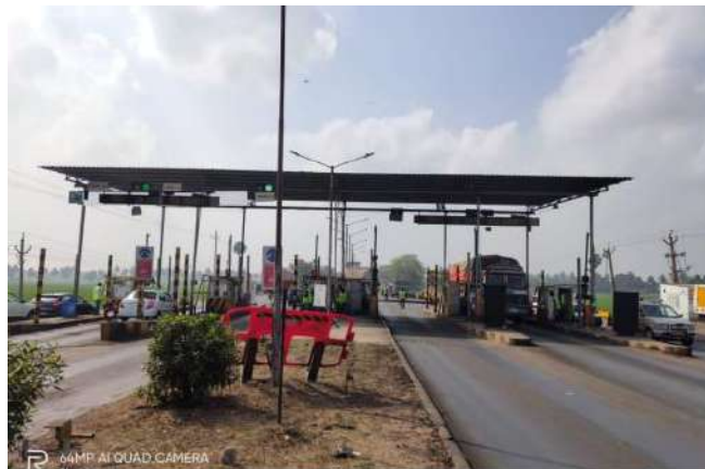
Fig. 5 Unguturu Toll plaza
